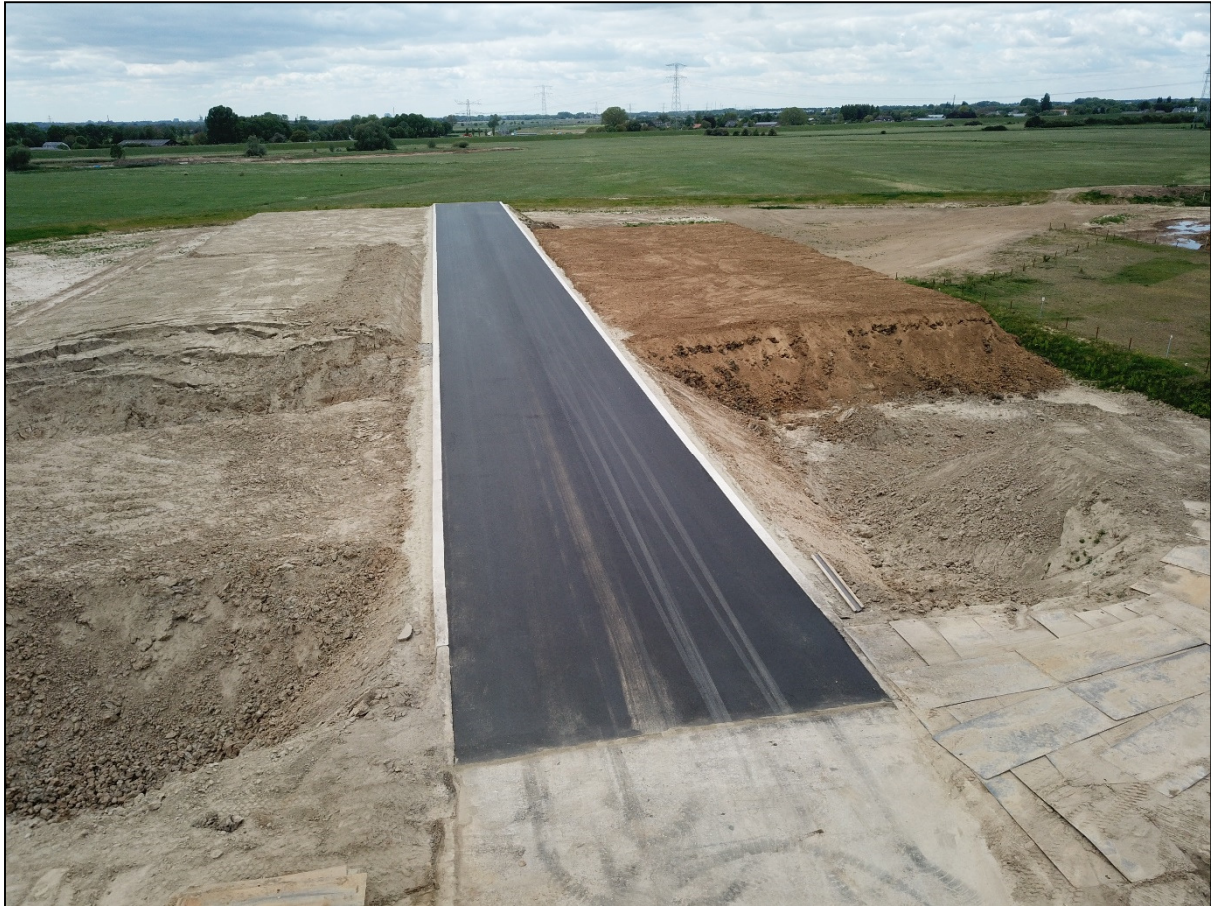
Figuur 15. Asfaltering binnen de uitbreiding van de steenfabriek.
