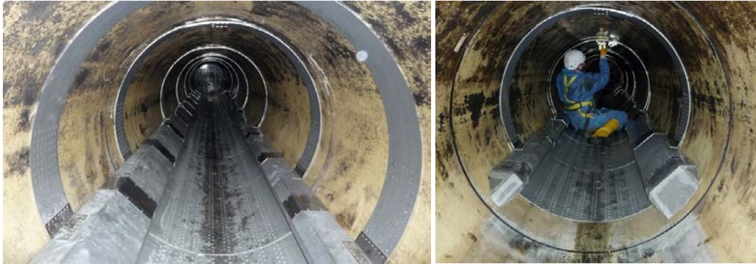
Figuur 2.2 Vrijvervalrioolwarmtewisselaar intern, deze wordt in schaaldelen ingebouwd (bron: Uhrig)
