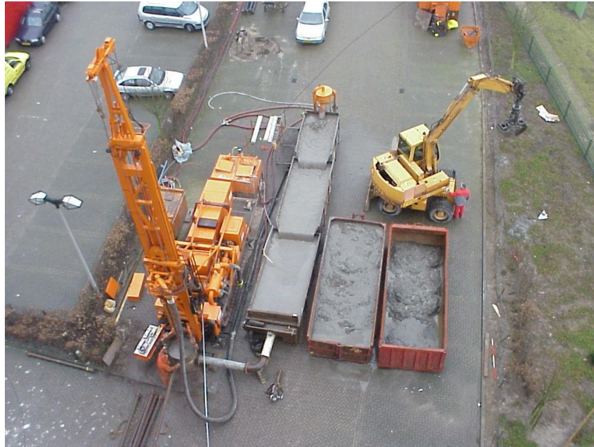
Figuur 3.14 Boorstelling zuigboren.
