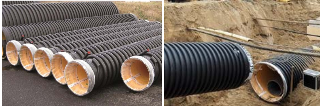
Figuur 2.4 Vrijvervalrioolwarmtewisselaar extern prefab gemeente Velsen
