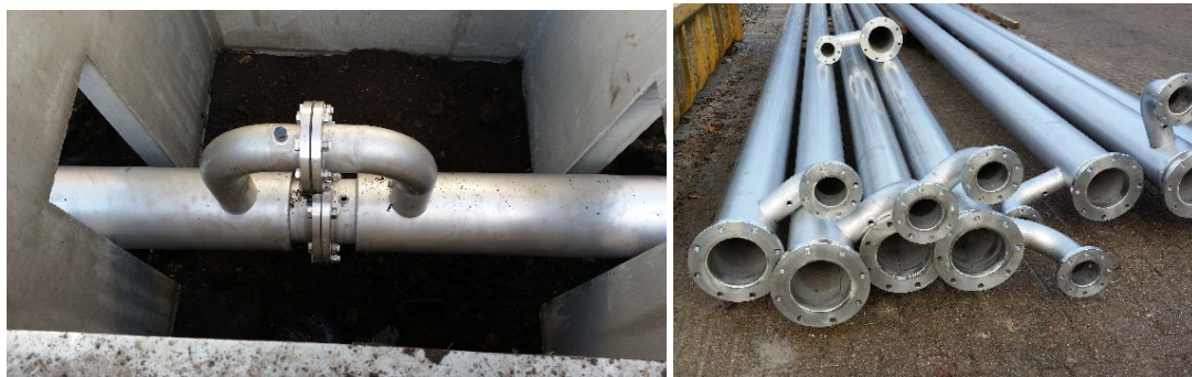
Figuur 2.5 Persleidingrioolwarmtewisselaar extern prefab, waarbij een dubbelwandige buis zorgt voor de warmteoverdracht
