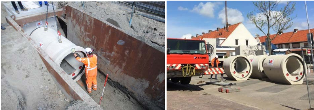
Figuur 2.3 Vrijvervalrioolwarmtewisselaar intern prefab in de gemeente Goes (bron: warmtepompen.nl)
