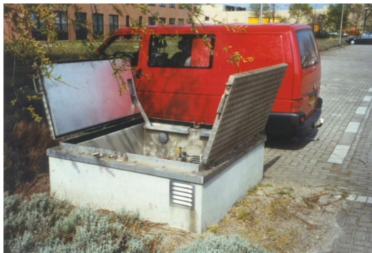
Figuur 3.15 Afwerking bron met half- bovengrondse putbehuizing
