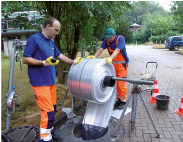
Figuur 2.6 Brandenburger rioolwarmtewisselaar (Brandenburger, 2019)
