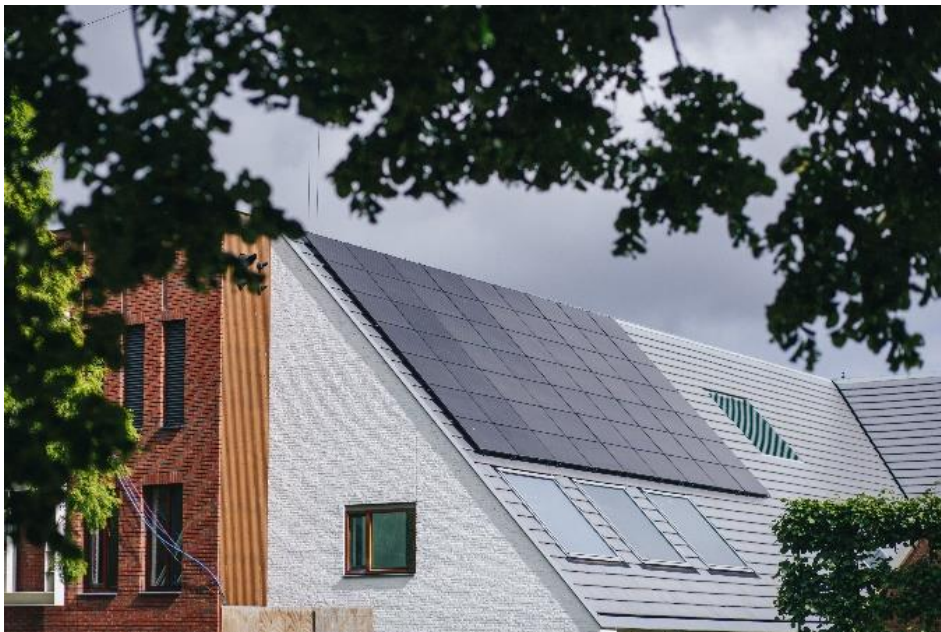
Zonnepanelen op het dak van het gemeentehuis
