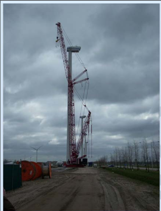
Windturbines in aanbouw, Amsterdam Westpoort
